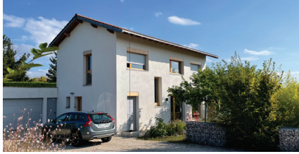
Maison basse énergie, Lucenay (69), Fabien Perret Architecture.
