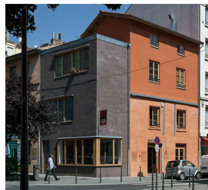
Surélévation et extension d'un immeuble de logements et restaurant en rez-de-chaussée, Lyon 7e (69), Fabien Perret Architecte
