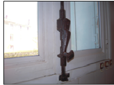
Crémone des fenêtres contenant de la peinture au plomb
